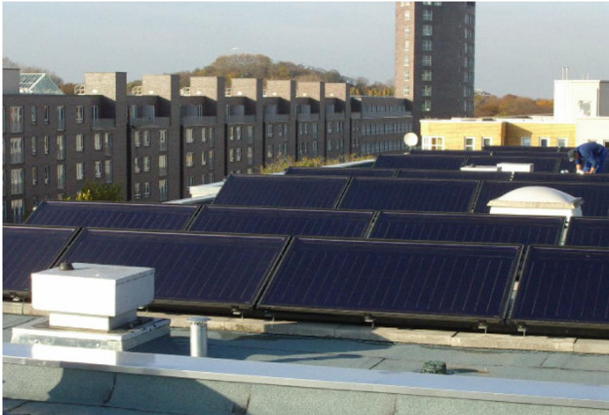
A lapos tető szigetelés megbontása nélkül biztonságos rögzítést hozhatunk létre nehezátekknők alkalmazásával!!!
